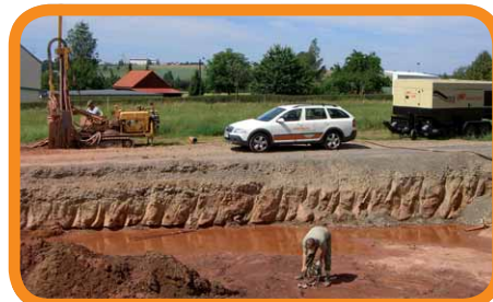
Messung eines Temperatur-Logs in der Baugrube
