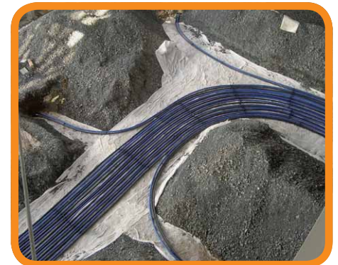
Horizontale Anbindung von Erdwärmesonden
