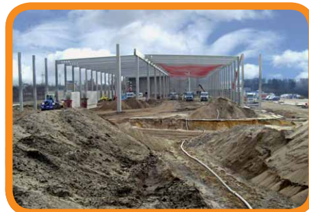
Logistikhalle der PANALPINA Welttransporte GmbH in Nürnberg
